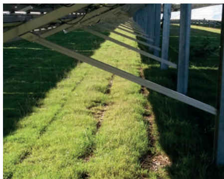
Photo 32 : Table fixe sur mono-pieu battu (© Idele)
