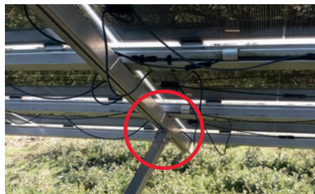
Photos 23 et 24 : Des supports et des coins de tables contendants pouvant blesser les animaux (© Idele)
