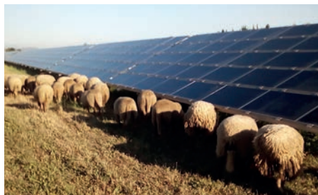
Photo 21 : Des hauteurs de tables parfois très basses (<1 m) (© Idele)
